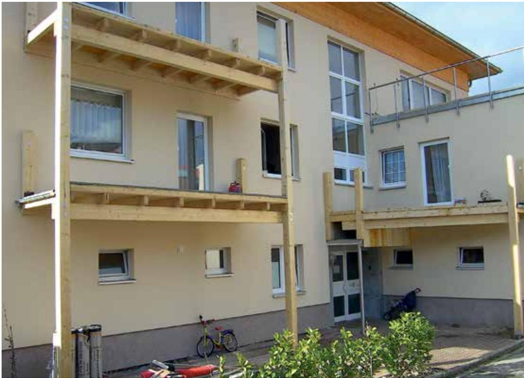
Die sichere Verankerung hoher Lasten erfordert eine genaue Kenntnis des Untergrundes, die passende Auswahl des Verankerungsmittels und eine zulassungskonforme Montage.
