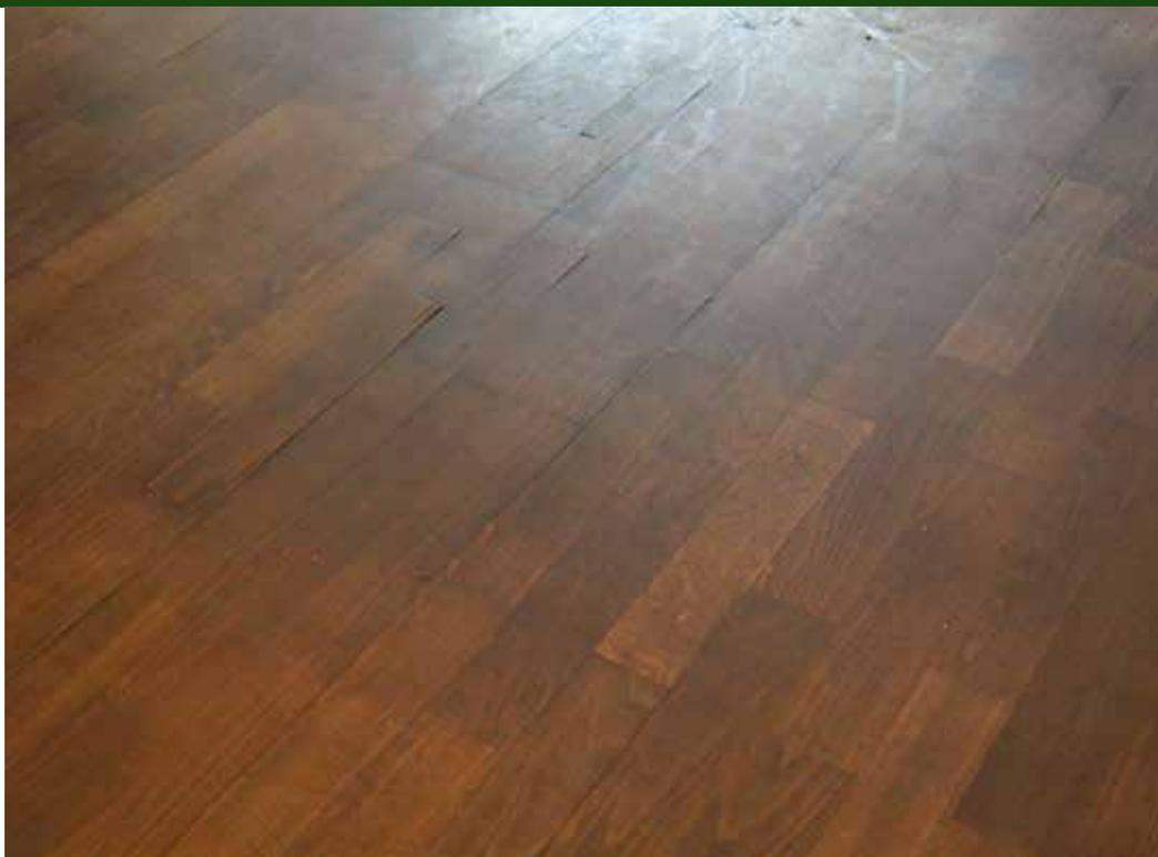
Eine zu hohe Feuchte aus dem Untergrund hat in diesem Beispiel zum Aufquellen der Holzfußboden-Elemente und in der Folge zu Verwerfungen im Verbund geführt.
